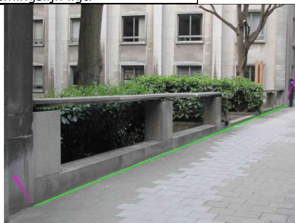
De muurtjes met een hoogte \leq 1 m worden voorgesteld in de laag « 242_Muret ».
