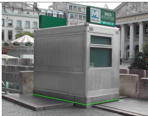
Loket van de MIVB (gesloten kiosk) opgenomen op grondniveau en voorgesteld in de laag « 215_Kiosque_ferme ».
