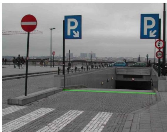
De lijn die het bovenste uiteinde van de toegangshelling naar een parkeerterrein markeert, wordt opgenomen.
