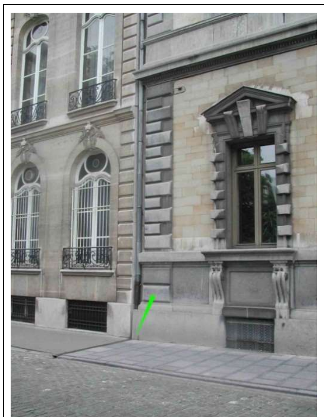
Bij terrestrische opname worden de gemene gevels opgenomen ter plaatse van de voet van de hoofdgevel.
