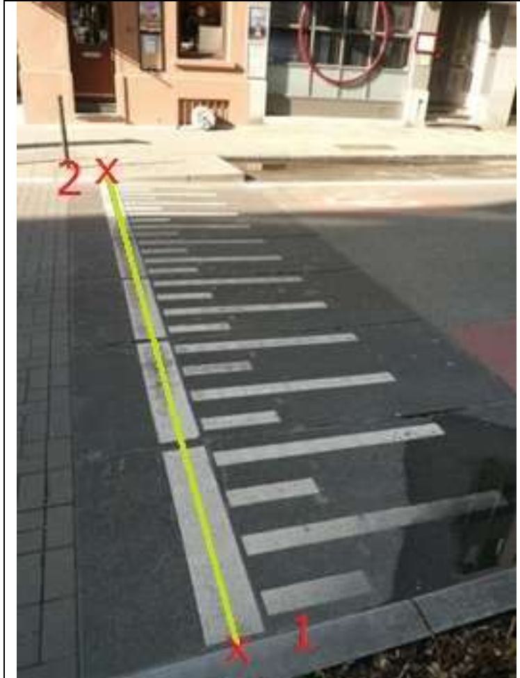
De wegmarkering voor verkeersdrempels wordt zodanig opgenomen dat de lijnen die de hellingshoek aangeven rechts liggen ten opzichte van de richting waarin de lijn wordt opgenomen.
