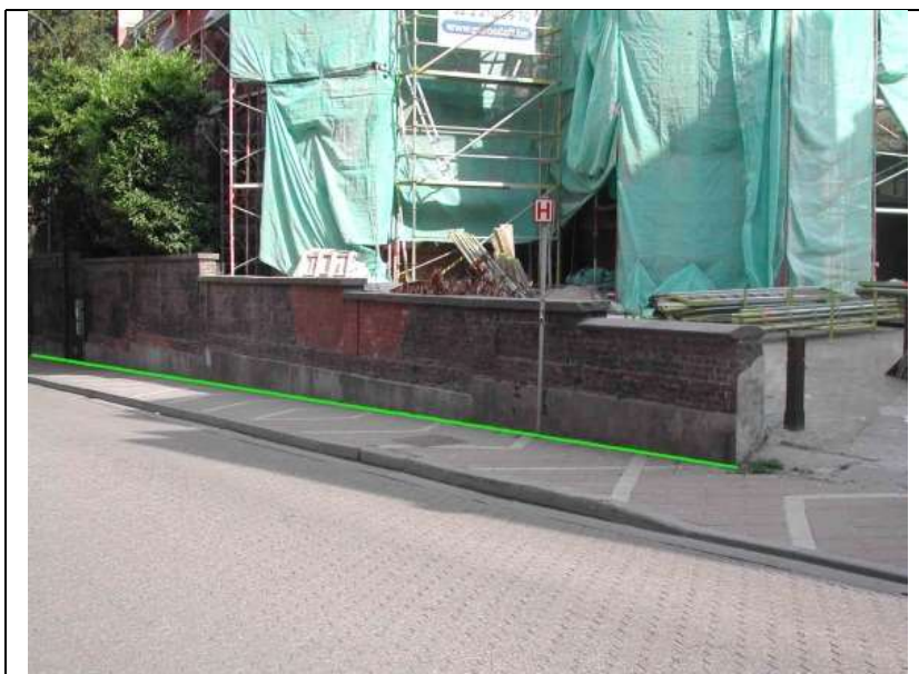
De muren met een hoogte groter dan 1 m worden voorgesteld in de laag « 240_Mur » Muren moeten zodanig opgenomen worden dat het metselwerk rechts van de opnemingslijn ligt.
