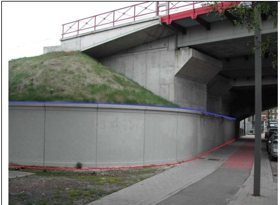
De voet van een steunmuur wordt voorgesteld in de laag « 270_Mur_soutenement » (rode lijn). De top van een steunmuur wordt voorgesteld in de laag « 270_Mur_soutenement ».
