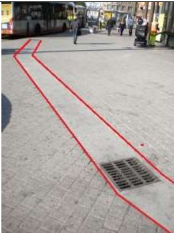
De twee randen van de watergreppels (afvoergeulen) worden opgenomen en voorgesteld in de laag « 381_Filet_eau ».
