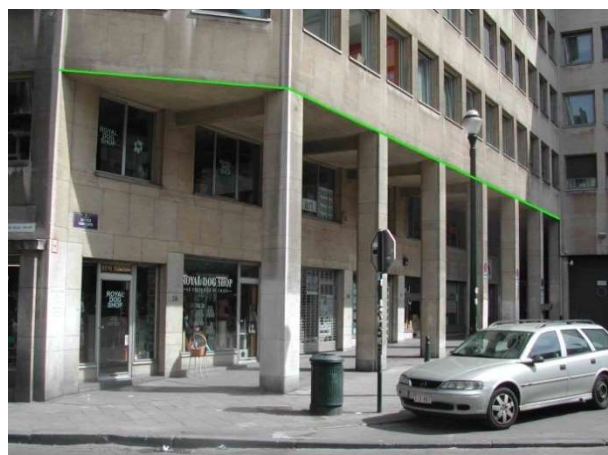
De uitkragende of vrijdragende gebouwdelen met pijlers worden altijd opgenomen en voorgesteld in de laag « 207_Porte_a_faux »
