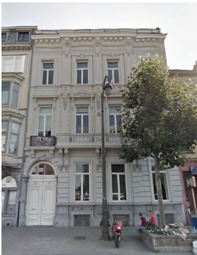
Vue de la façade principale bld d'Anvers
