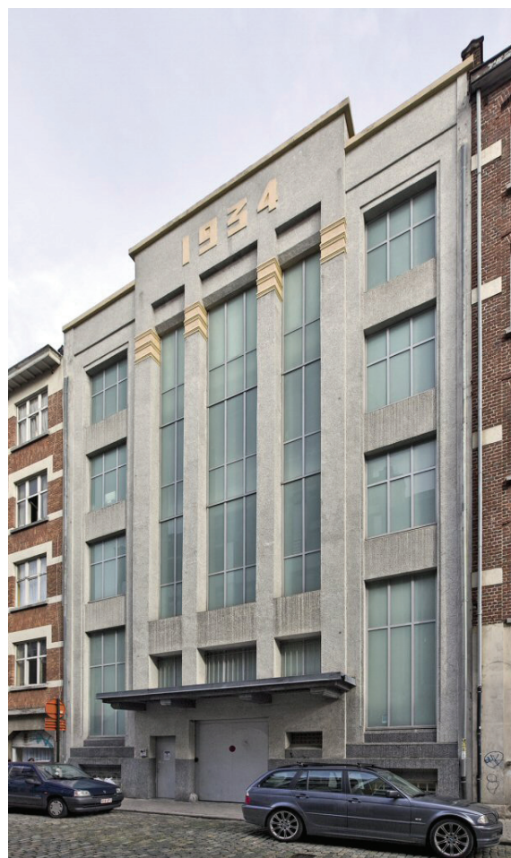
Vue de la façade de l'entrepôt rue des Commerçants
