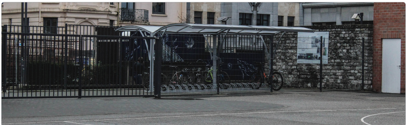
7. Overkapte fietsenstalling met roosters als zijwanden - Institut Saint-Louis, Namen
