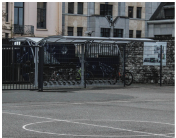
10 - Parking vélo couvert entouré de parois grillagées - Institut Saint-Louis, Namur
