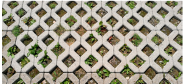
9 - Revêtement en dalles ajourées
