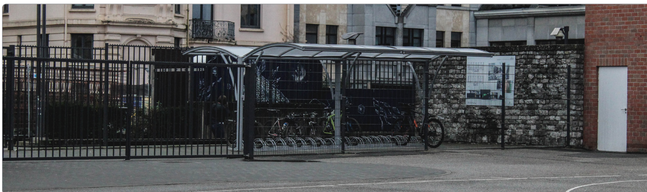
7 - Parking vélo couvert entouré de parois grillagées - Institut Saint-Louis, Namur
