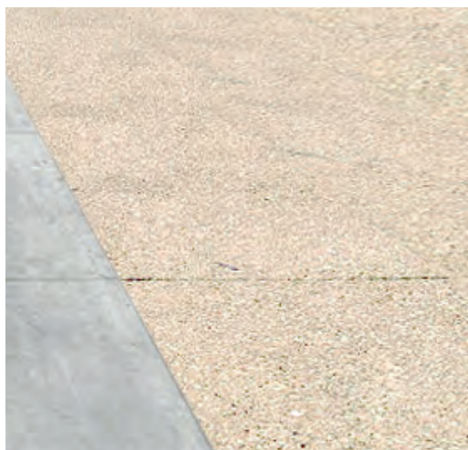
béton coulé clair voie tram/bus
