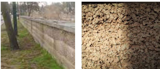
Détail type du mur acoustique en béton caverneux
