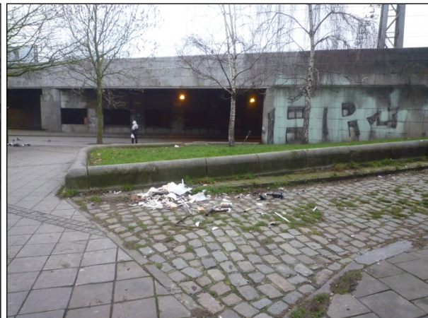
Foto 20: Storting van afval ter hoogte van de groene ruimte op de hoek van de Aarschotstraat
