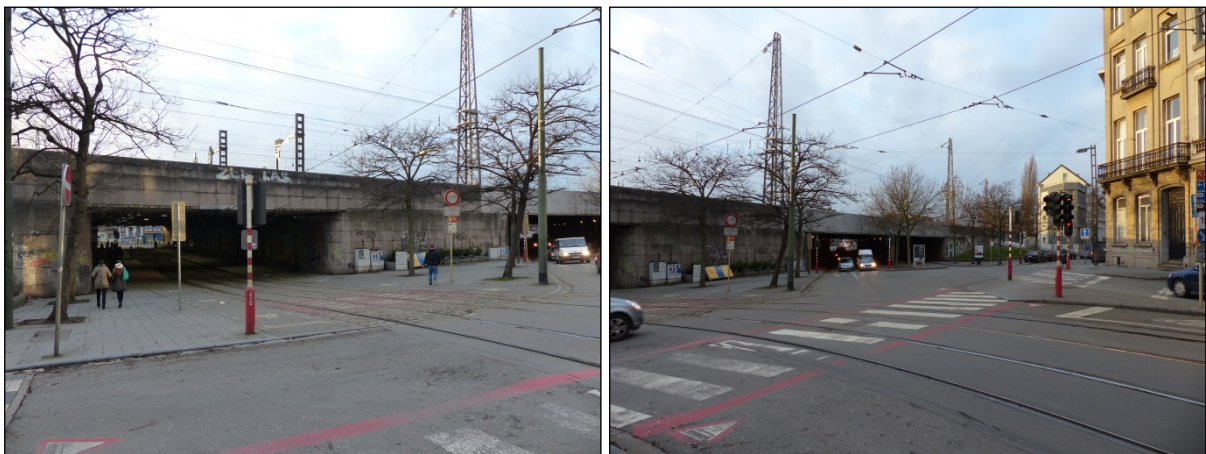
Foto 16: Kruispunt Thomastunnel – Koninginnelaan –Aarschotstraat
