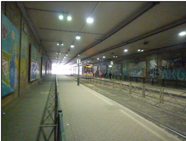
Foto 17: Binnenkant van de Thomastunnel
