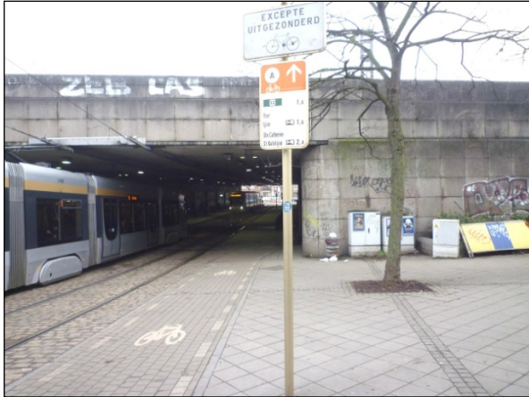
Foto 7: Trottoir en fietspad in de Thomastunnel
