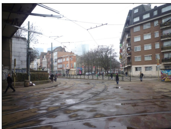
Foto 5: Uitgang van de Tunnel naar de Thomasstraat
