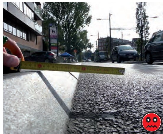
Figuur 50 – Charles Woestelaan, boordsteen – De boordsteen van het fietspad in de Charles Woestelaan blijkt voor veel fietsers geen goede keuze te zijn om ‘gemakkelijk’ terug op te kunnen rijden.
