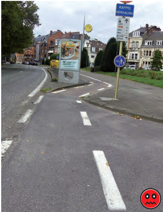
Figuur 45 – Lambermontlaan – Foute asverlegging.
