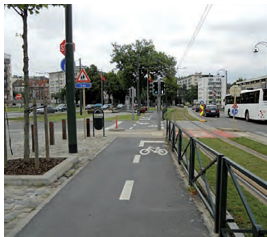
Figuur 28 – Vorstlaan, Oudergem, centraal gelegen dubbelrichtingsfietspad – Dit dubbelrichtingsfietspad zou normaal gezien in okerkleurig asfalt moeten zijn uitgevoerd.
