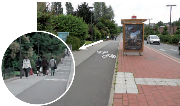
Figuur 27 – Louis Dehouxlaan, Oudergem, dubbelrichtingsfietspad – In dit voorbeeld van een dubbelrichtingsfietspad zorgt de overhangende haag voor hinder op het voetpad en door het ontbreken van hekken aan de halte kunnen ook conflicten tussen fietsers en voetgangers ontstaan. Het dubbelrichtingsfietspad is te smal.
