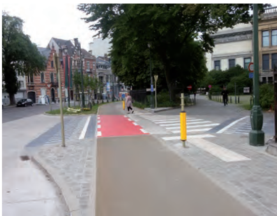
Figuur 73 – Nerviërslaan: het fietspad gaat rechtdoor over het kruispunt, op een verkeersplateau – In dit voorbeeld gaat het om een dubbelrichtingsfietspad, idealiter werd dit ondersteund door fietslogo's in beide richtingen.
