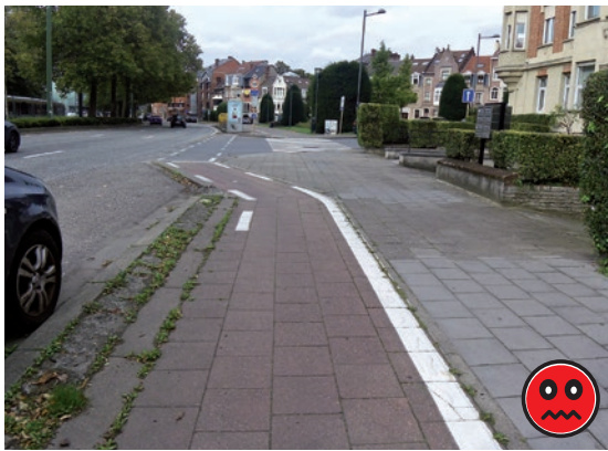
Figuur 4 – Lambermontlaan – Fietspad wordt ingebogen ter hoogte van kruispunt. Parkeerplaatsen hadden 15 à 30m voor het kruispunt opgeheven moeten worden om een goede zichtbaarheid te garanderen.
