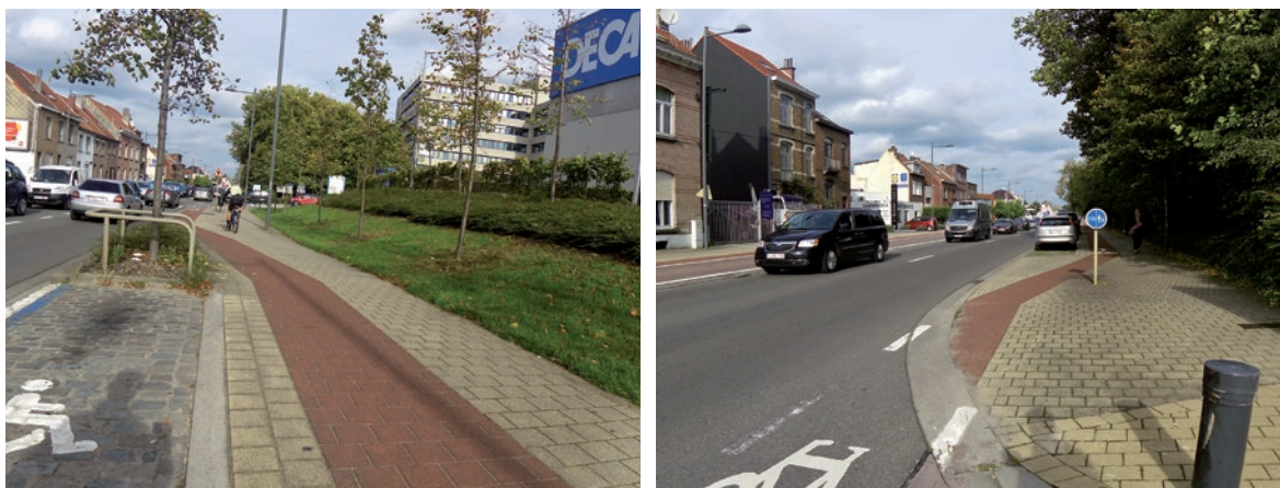
Figuur 3 – Haachtsesteenweg – Het vrijliggend fietspad wordt ingebogen ter hoogte van het kruispunt (GFP). De maatvoering is in dit voorbeeld ondermaats.
