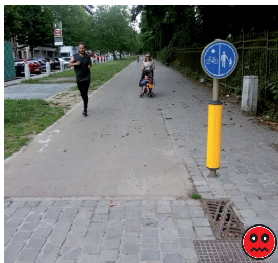
Figuur 42 – Renaissancelaan, D9 – Bij deze inrichting, aangeduid door D9-bord, gaan voetgangers systematisch gebruikmaken van het deel dat voor fietsers is voorbehouden. Reden hiervoor is het gebruik van een comfortabeler materiaal voor het fietspad dan voor het voetpad.
