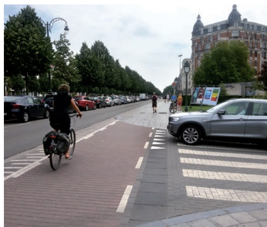
Figuur 47 – Tervurenlaan – Fiets- en voetgangersoversteekplaats tussen twee voorzieningen die met een D10-bord zijn aangeduid.
