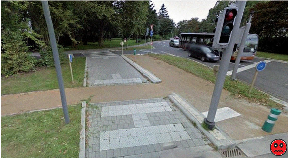
Figuur 20 – Leopold III-laan – Wanneer twee fietspaden elkaar kruisen, moet dit zo vorm worden gegeven dat fietsers veilig van het ene fietspad naar het andere fietspad kunnen rijden. Zij kunnen geen hoeken van 90° nemen.
