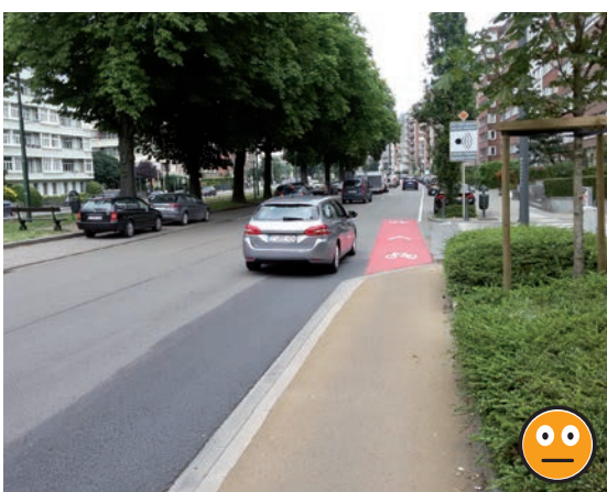
Figuur 18 – Louis Schmidlaan – Einde D9 fietspad en gaat over naar gemengd verkeer. Het is evident dat het ontbreken van een fietspad op zo'n verkeersas niet aan te bevelen is.
