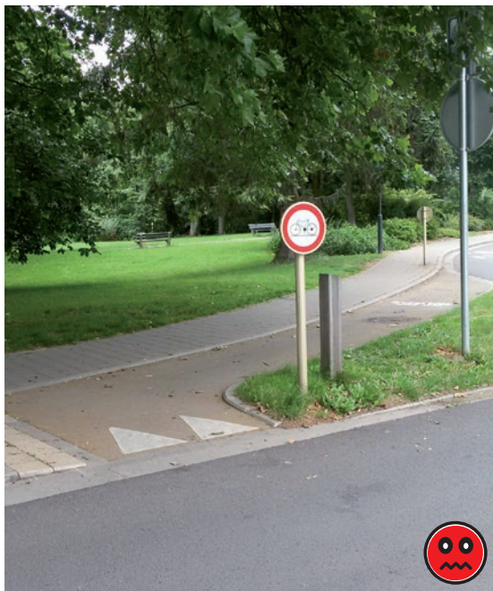
Figuur 23 – Leopold III-laan – Haakse aansluiting van het fietspad op de rijbaan. Dit is niet fietsvriendelijk (gevaarlijk) voor fietsers. Door deze vormgeving zullen wachtende fietsers eveneens gedeeltelijk op het voetpad staan, wat hinderlijk is voor de voetgangers.
