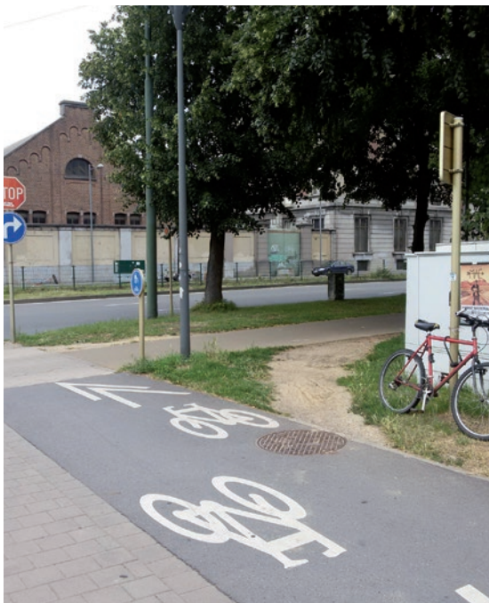
Figuur 21 – Pleinlaan – Fietsers zoeken vaak de weg van de minste weerstand, ook als dit infrastructureel niet ondersteund wordt. In het voorbeeld hierboven is een 'olifantenpaadje' ontstaan doordat fietsers die rechtsaf willen slaan, systematisch voor de gemakkelijkste route kozen (meest logische) route kozen.
