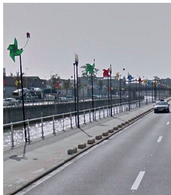
Figuur 24 – Koolmijnkaai – Oude situatie met D7-bord – men had beter de volledige breedte als één zone ingericht, al dan niet met een F99a-statuut, in functie van de fiets- en voetgangersstromen.
