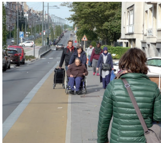
Figuur 41 – Charles Woestelaan – Voetgangers maken ook gebruik van het fietsgedeelte.
