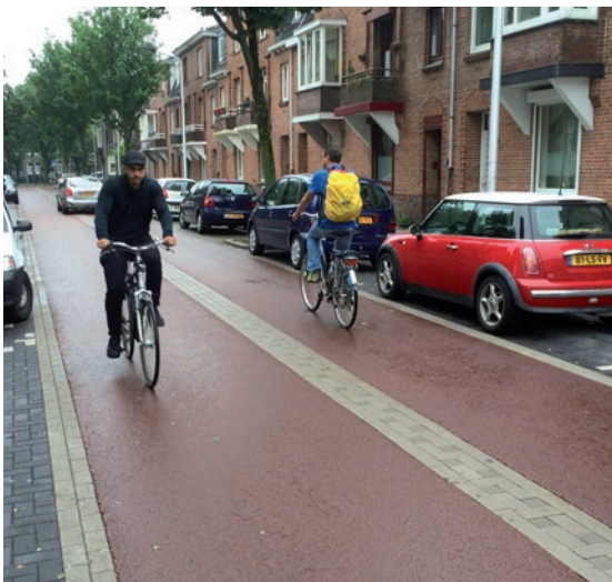
Centraal gelegen strook in betonklinkers in een fietsstraat met dubbelrichtingsverkeer in Maastricht.
