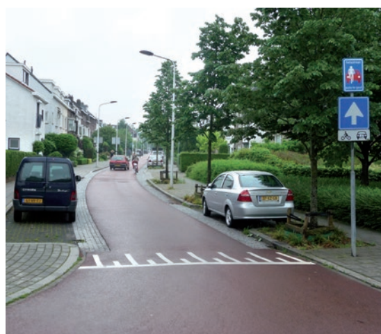
Als verkeersplateau uitgevoerd kruispunt aan het begin van een fietsstraat in Maastricht.
