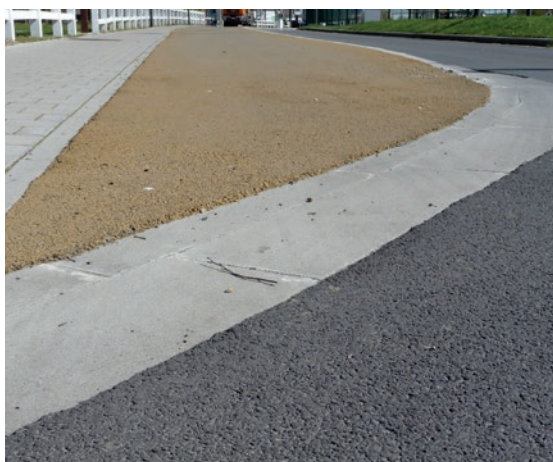
Okergele asfaltverharding op het voor fietsers bestemde deel van een D9-voorziening.
