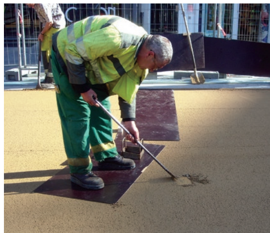
Een gekleurde verharding moet met zorg worden aangebracht voor een esthetische afwerking (in dit voorbeeld: houtplaten gebruiken om over het werkvlak te lopen).
