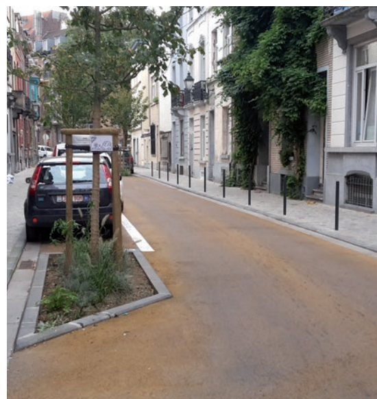
Zichtbare bevuiling van een gekleurde beton (boven) en een gekleurde bitumineuze (onder) verharding, die onderhoud en geregeld schoonmaken nodig maakt.
