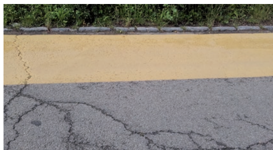
Voorbeeld van een verharding waarop een hoogwaardige bestrijking is aangebracht.
