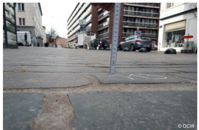
Gezaagde porfierstenen met een identiek oppervlak maar een verschillend comfort (gemeenteplein in Molenbeek): links voegen van \pm 4 mm diep, comfort = 5,6/10; rechts: voegen van \pm 1 mm diep, comfort = 7,5/10
