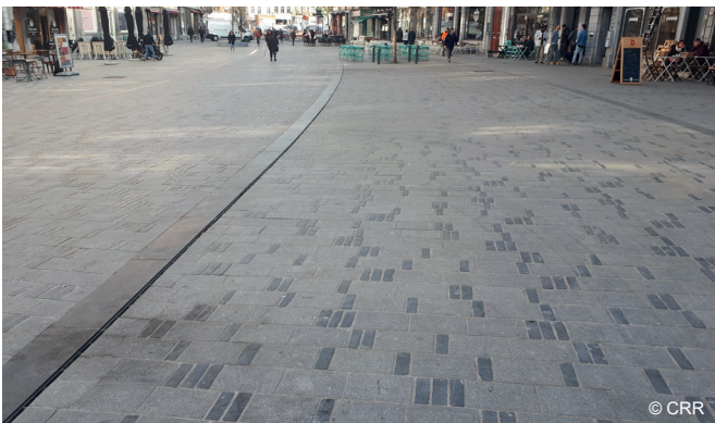
Natuursteenbestrating met afwisselend gepolijste en onbewerkte straatkeien (links). Aan de gepolijste oppervlakken te zien, is het gevaar om uit te glijden links hoger dan rechts, waar er minder gepolijste stenen tussen de granietstenen liggen
