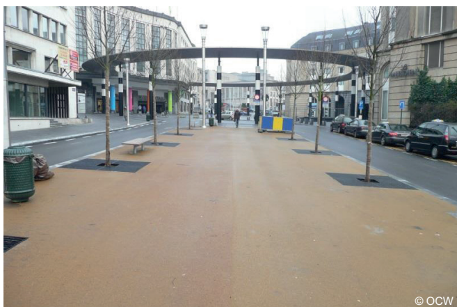
Doorgaande voetgangersverhardingen van gekleurd asfalt (links - Keizerinlaan) en beton (rechts - Steenkoolkaai), met een uitstekende gebruikskwaliteit voor de voetgangers
