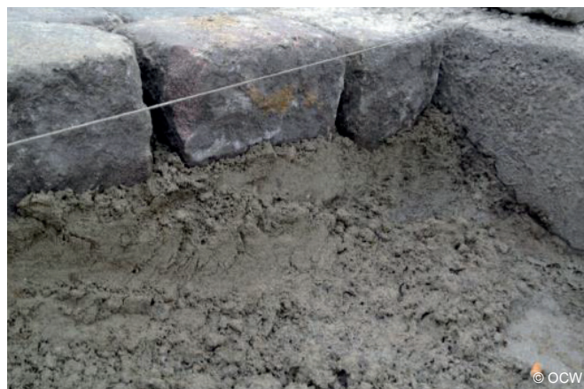
Straatlaag van zandcement
