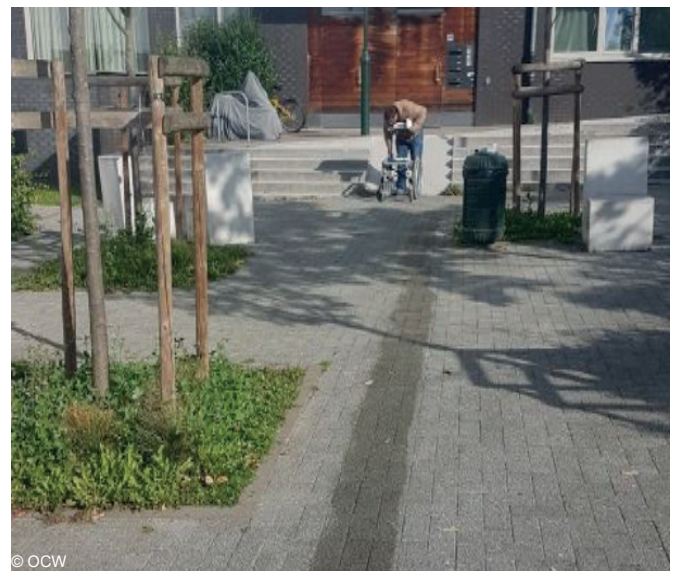
Over de volle dikte waterdoorlatende betonstraatstenen in een nieuwe openbare ruimte in Vorst
