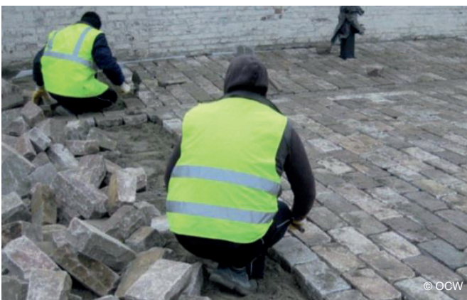
Inbedden van straatkeien in een straatlaag
