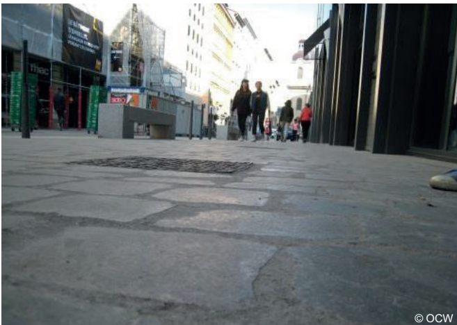
Natuursteenverharding met een vlak oppervlak en hoog opgevulde voegen in Lyon
