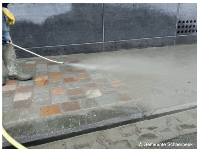
Reiniging van de bestrating met behulp van een straalbreker, zodat het water bijna evenwijdig met het oppervlak van de bestrating kan worden gespoten (bron: gemeentebestuur van Schaarbeek)
