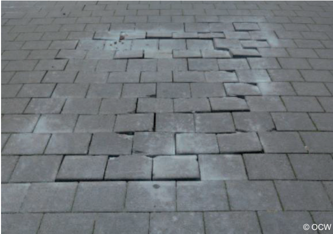
Verminderde gebruikskwaliteit door werkzaamheden van een nutsbedrijf, waardoor opbreken en correcte heraanbrenging vereist zijn
