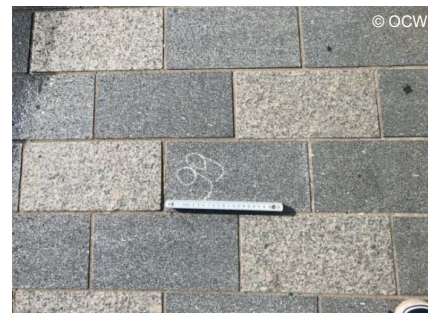
Gezaagde en gevlamstraalde granietkeien op het Spiegelplein (Jette), met een zeer goede gebruikskwaliteit (comfort = 10/10, stroefheid (PFT) = 0,69)
