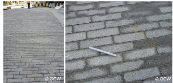
Gezaagde straatkeien van gebouchardeerde blauwe hardsteen op een voetgangersvoorziening in Brussel, met een zeer goede gebruikskwaliteit (comfort = 9,5/10, stroefheid (PFT) = 0,85)
