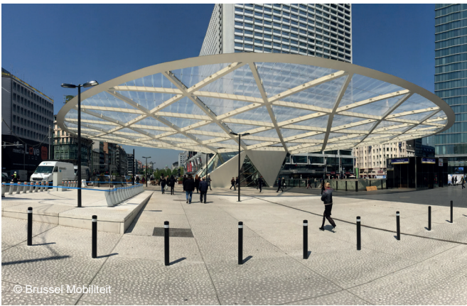
Een te lichtgekleurde verharding verblindt de gebruiker
