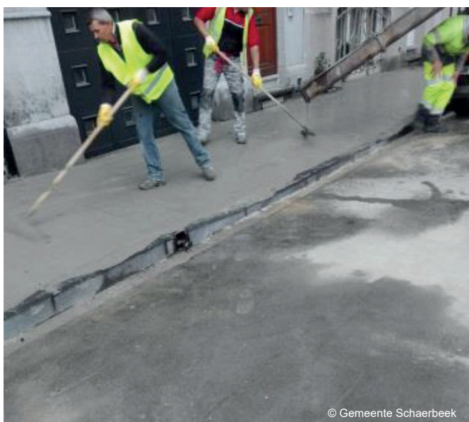
Vullen van de voegen met gemodificeerde mortel in Schaarbeek (Pelletierstraat)
