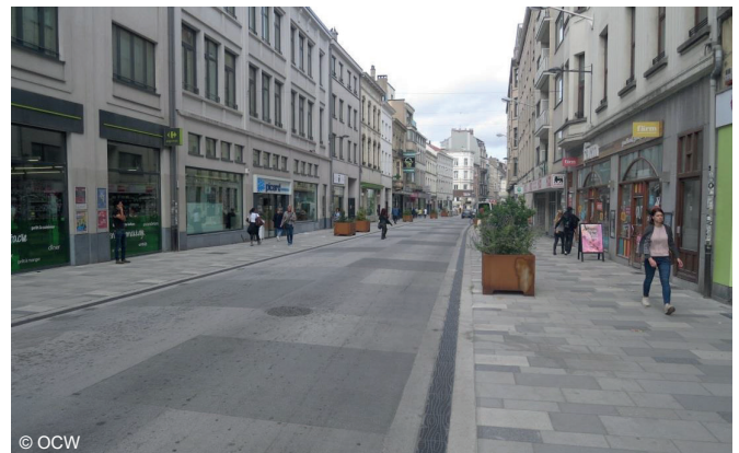
Elsensesteenweg (Elsene): voetgangersverhardingen van gekleurde betonstraatstenen met een zeer goede gebruikskwaliteit
