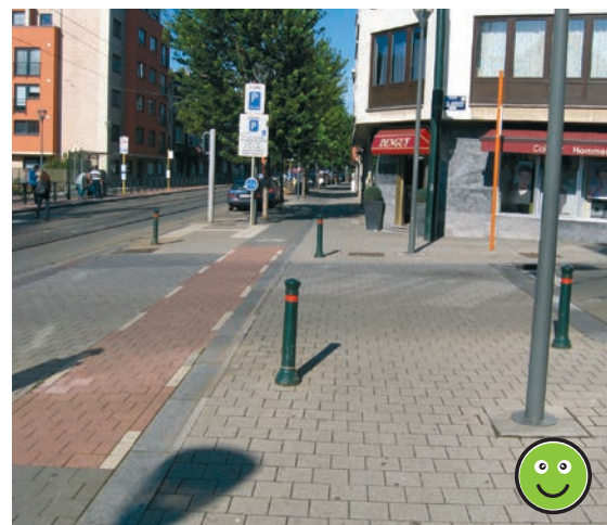
Conform doorlopend trottoir (constant niveau en zelfde kleur).
