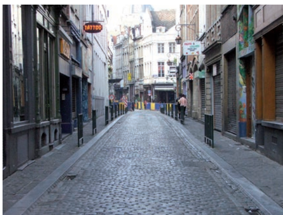
Voirie avec séparation en trottoir et chaussée et susceptible de devenir une zone de rencontre vu le contexte local et l'étroitesse des trottoirs.
