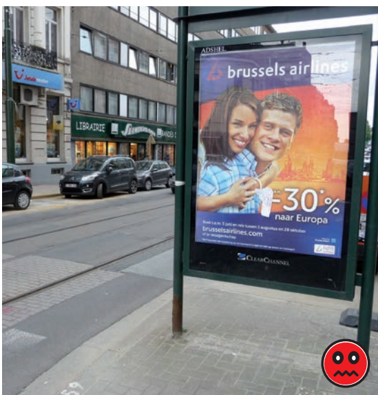
Panneau publicitaire non conforme (pas de barre horizontale à maximum 30 cm du sol) masquant le piéton prêt à traverser.
