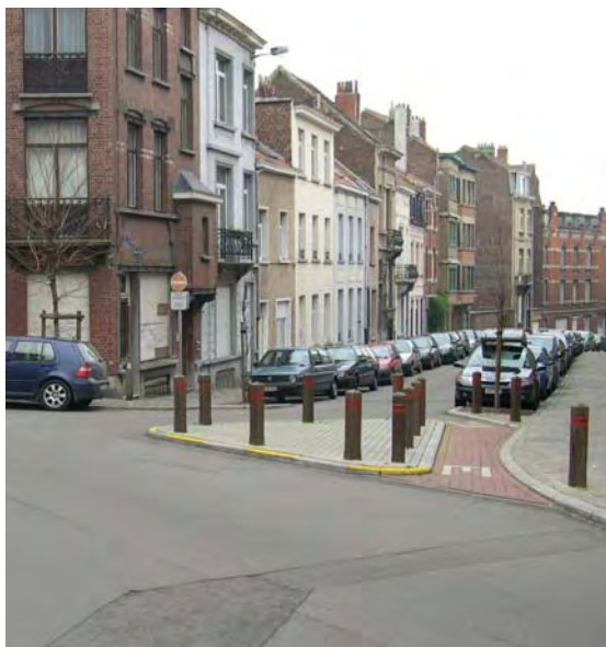
Figuur 9.1. – Trottoiruitstulping met een voor fietsers berijdbare bypass aan het begin van een voor fietsers toegelaten tegenrichting.
