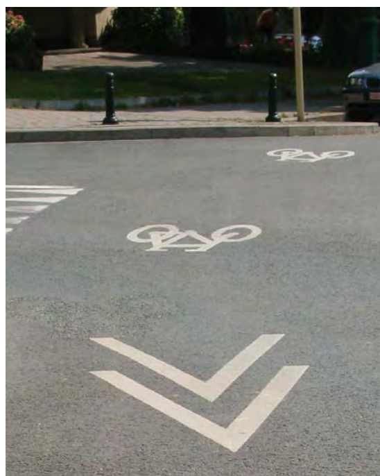
Figuur 1.3. – Dubbele sergeantstreep op een fietsroute.
