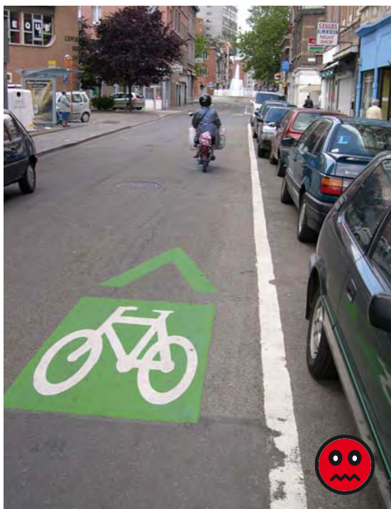
Figuur 1.2. – Herhaling van enkelvoudige sergeantstrepen. Het gebruik van de (vooral bij regen) weinig zichtbare kleur groen moet afgeschaft worden. De sergeantstrepen (en de pictogrammen) moeten in het wit aangebracht worden.
