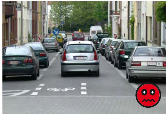
Figuur 1.1. – Tegenvoorbeeld. Aanzet van GFP in tegenrichting op een smalle rijbaan: de wagen wordt gedwongen om over de fietsmarkering te rijden, wat feitelijk verboden is. Het gebruik van sergeantstrepen omzeilt dit probleem.
