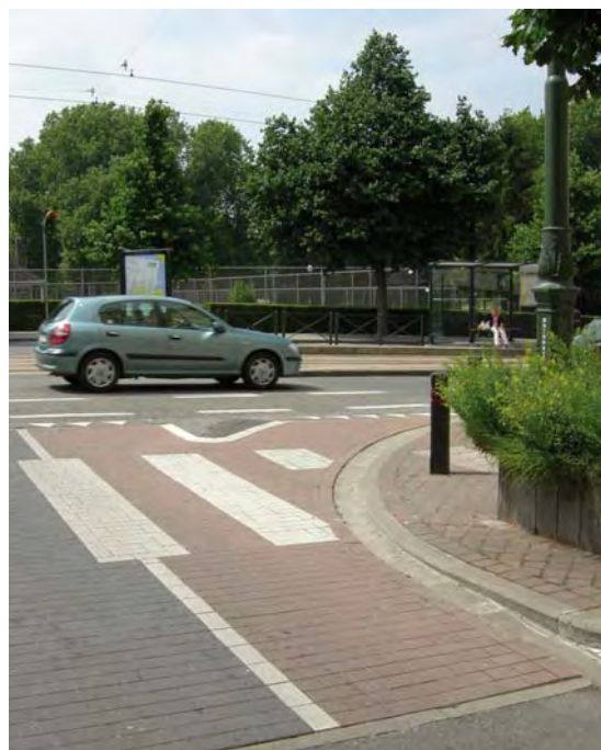
Figuur 4.5. – Einde van fietsen in tegenrichting, uitgevend op een voorrangsweg: interessant, maar minder gemakkelijk te begrijpen voor automobilisten doordat er geen fietspictogram is.
