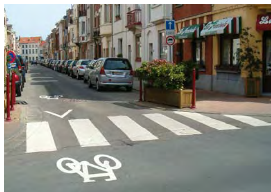
Figuur 2.1. – Deze markering met fietslogo en sergeantstreep is duidelijk zichtbaar voor voetgangers die op het punt staan om over te steken, voor bestuurders die de straat met beperkt eenrichtingsverkeer moeten inrijden, of die voorrang moeten geven aan fietsers die van rechts komen.
