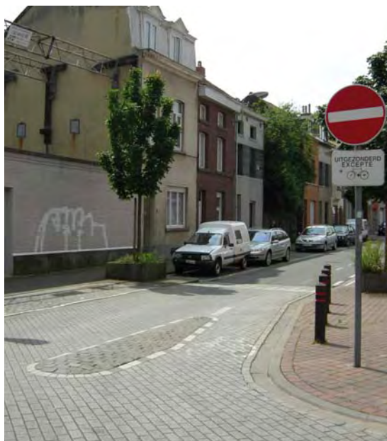
Figuur 5.5. – Een verkeerseiland zoals hier afgebeeld, benadrukt de aanwezigheid van fietsers en zorgt ervoor dat motorvoertuigen gescheiden worden van fietsers. Het kan aangebracht worden als aanvulling bij een markering.
