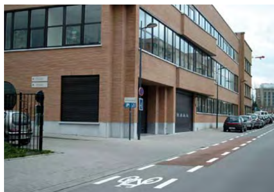
Figuur 6.2. – GFP in tegenrichting voorzien van een "overmarkering" van rode coating vóór een garage-uitrit.
