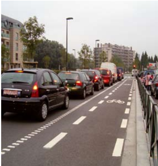
Figuur 3.9. – Sauwenslijn uitgevoerd als ribbelreflexstreep.
