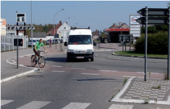
Figuur 4.12 – De kans dat de trajecten van de weggebruikers op deze foto elkaar snijden, wordt nog vergroot door de aanwezigheid van een gemarkeerd fietspad op de rondgaande rijbaan (ongevalstype 2). Ook het risico dat fietsers die de rotonde oprijden niet opgemerkt worden door automobilisten, neemt hierdoor toe (ongevalstype 1).
