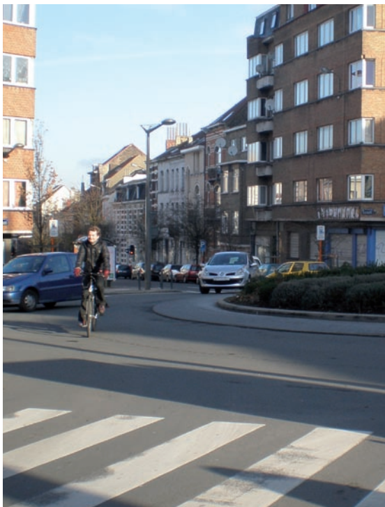
Figuur 4.4 – Compacte rotonde (zoals afgebeeld) of mini-rotonde met gemengd verkeer, de veiligste rotonde voor fietsers.
