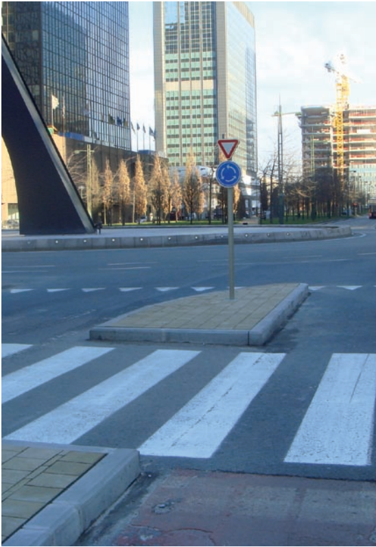
Figuur 4.8 – In het verlengde van een fietspad, laat deze inrichting de fietsers die op het fietspad rijden toe de file voorbij te rijden tot aan de rotonde. Ze vallen echter buiten het gezichtsveld van de automobilisten ter hoogte van de rotonde vermits deze hun aandacht vooral vestigen op het van links aankomend verkeer.
