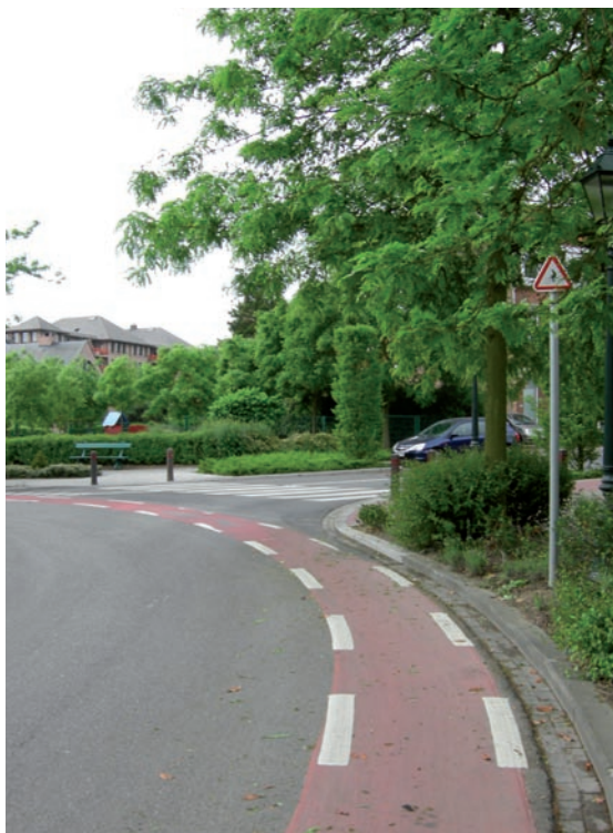
Figuur 2.5 – Het gemarkeerd fietspad op de rotonde is geen goede oplossing voor de veiligheid van de fietsers. Het verkeersbord A25 dat werd toegevoegd zal daar niet veel aan veranderen.
