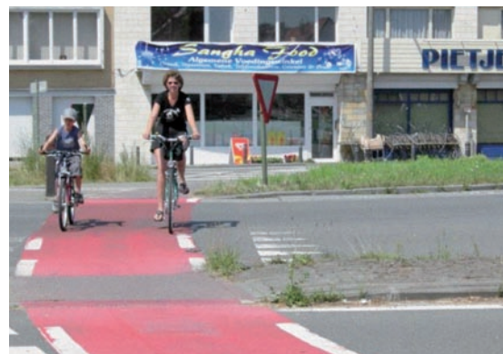
Figuur 4.15 – Het is aanbevolen om vóór het zebepad witte omgekeerde driehoeken aan te brengen, en om voorrangfietspaden aan te brengen op een gekleurde ondergrond, zoals op het voorbeeld hierboven in Vlaanderen.
