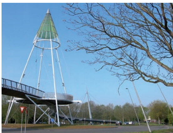
Figuur 4.27 – Fietsersbrug in Drachten (NL) over een tweestrooksrotonde.
