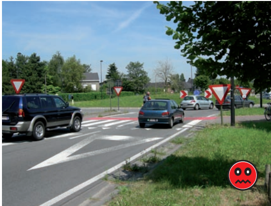
Figuur 4.17 – Het aanbrengen van een vrijliggend fietspad in de voorrang wordt ten strengste afgeraden indien 2 rijstroken in dezelfde rijrichting als toe- of afrit van een rotonde moeten worden gedwarsd.
