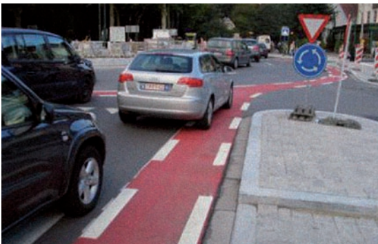
Figuur 4.13 – Het feit dat het fietspad op de toerit doorloopt op de rotonde, is geen veiligheidsgarantie voor fietsers, zo blijkt uit bovenstaande foto.
