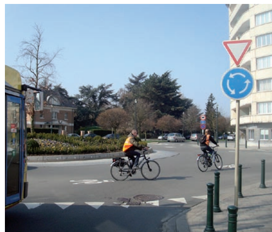
Figuur 4.5 – De markering van een fietssuggestiestrook wordt aangebracht in het midden van de rondgaande rijbaan op de optimale plaats voor de fietser. Daarenboven is het niet nodig de optimale plaats om de rotonde te verlaten te benadrukken indien dit op een natuurlijke wijze kan gebeuren.
