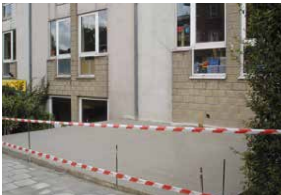
Ouders van basisschool Aurora en de gemeente werken samen bij de realisatie van de vloer van een nieuwe fietsparking.
