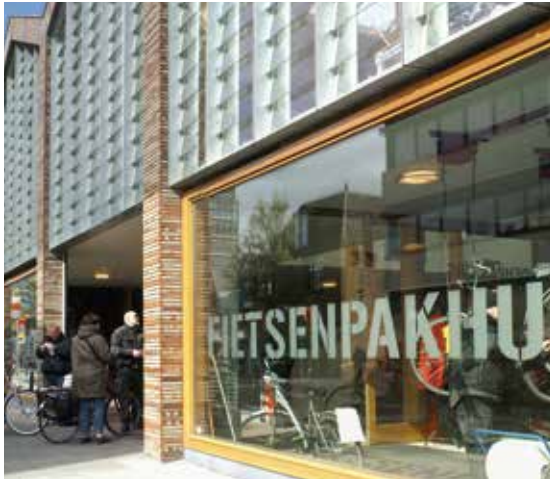
Het fietsenpakhuis in Zaandam voor de bezoekers van de winkels in de binnenstad.
