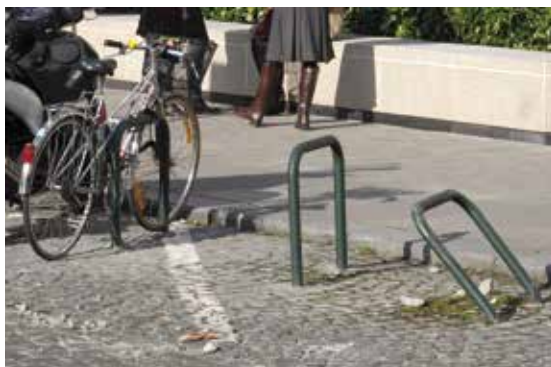
Links: een breed parkeervlak waarbij de beugels haaks op de weg kunnen worden geplaatst. Rechts: een smal parkeervak van twee meter waarbij de beugels onder een hoek van 45° worden geplaatst.
