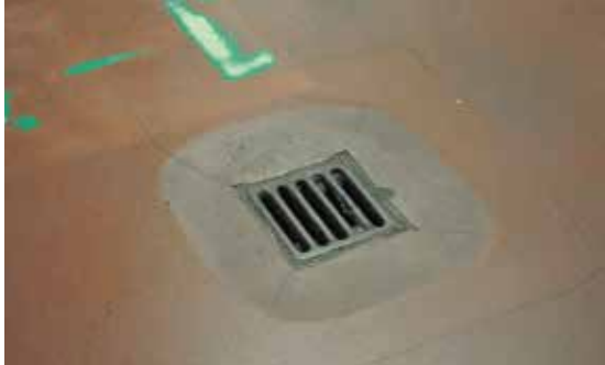
Afvoerput op het laagste punt van de stalling.
