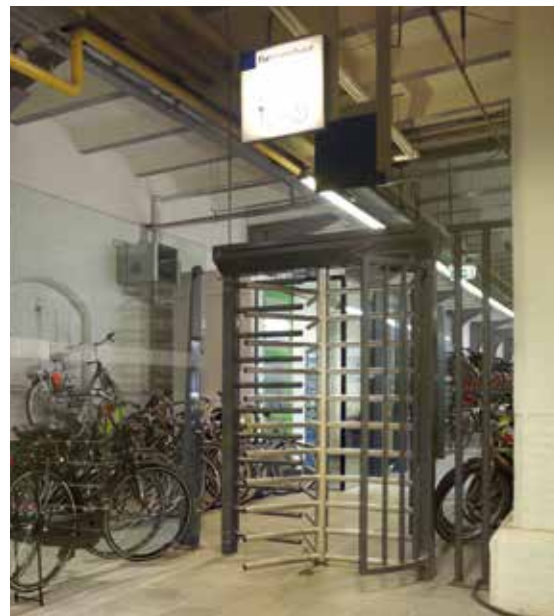
Tourniquetdeur in station Haarlem als gecombineerde in- en uitgang. Geen fiets komt hier door, hoogstens erover. Nadeel is dat bij drukte slechts één persoon tegelijk door de deur kan.
