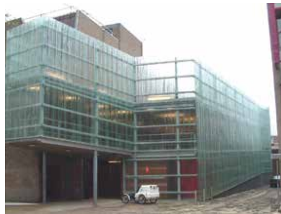
Hellingbaanparkings in Apeldoorn 'de glazen fietsmachine'.
