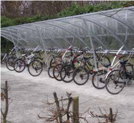
Fietsenstalling aan de Europese school.
