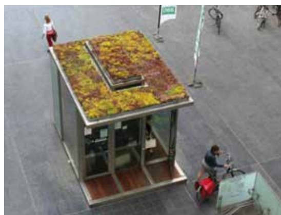
Fietsenstalling met een groendak door grassroofcompany.co.uk.
